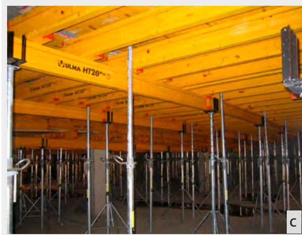
Abb. 5-5: Beispiel für Methode 5.1.2: Lose-Träger-Schalung [Quelle: ULMA]
