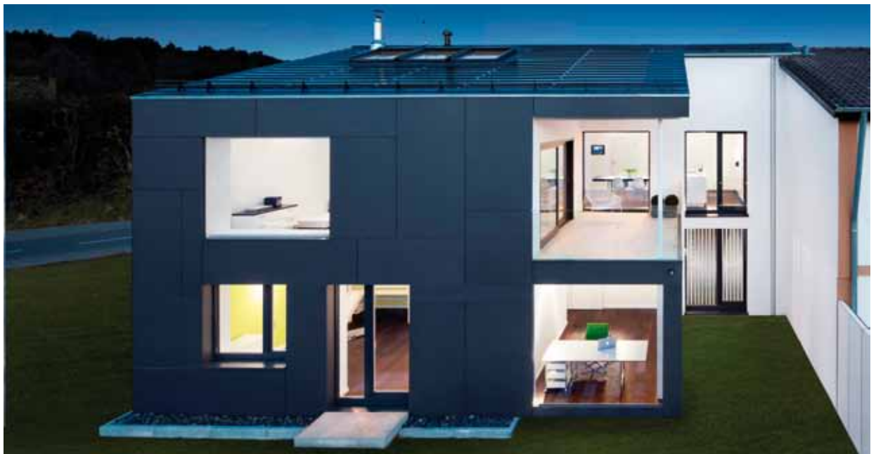
Bild 1: Westfassade des energy + Home
