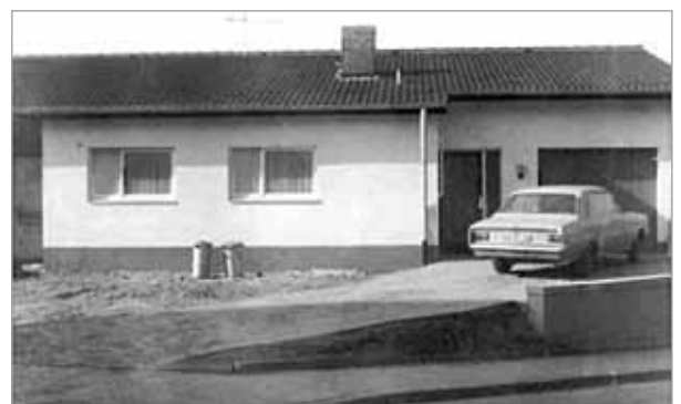
Bild 2: Ostfassade des Bestandsgebäudes
